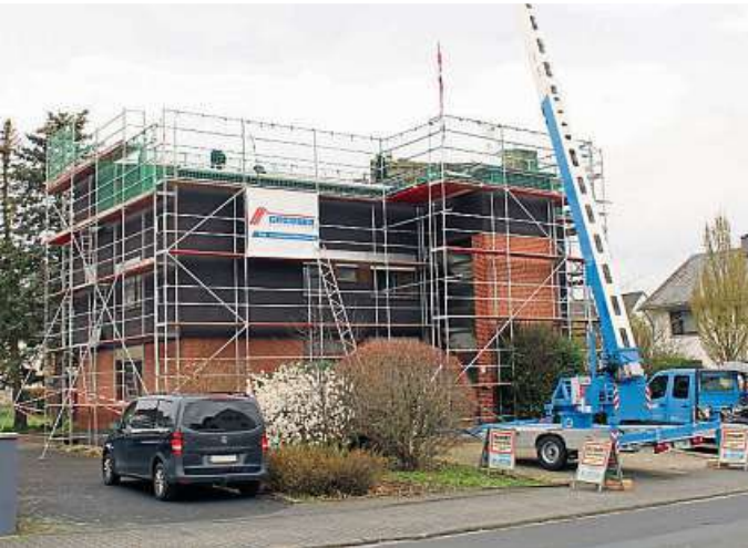
Wenn die Umbau- und Sanierungsarbeiten am früheren Pfarrhaus St. Marien weiterhin planmäßig verlaufen, soll das zentrale Pfarrbüro Ende des Jahres bezugsfertig sein. Foto: Dieter Fluck
